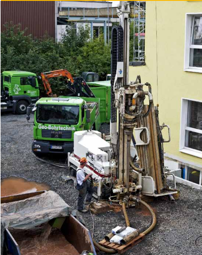
Erdsondenbohrung
