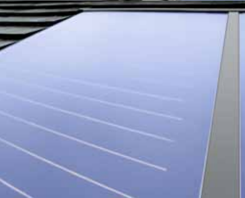
Solarkollektor (Indach)
